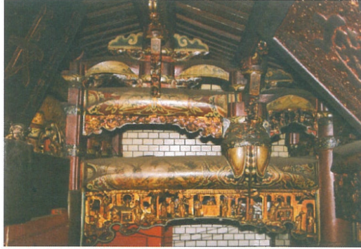
■ 三川殿棟架修復前
